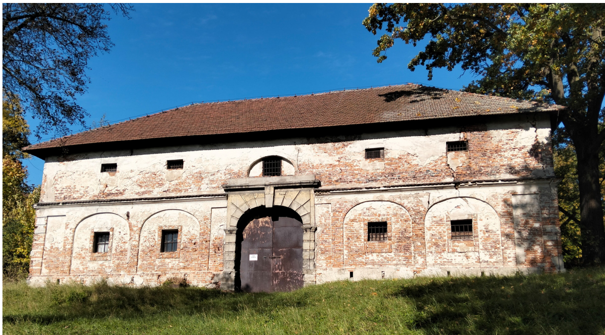
Budynek spichrza – stan obecny
